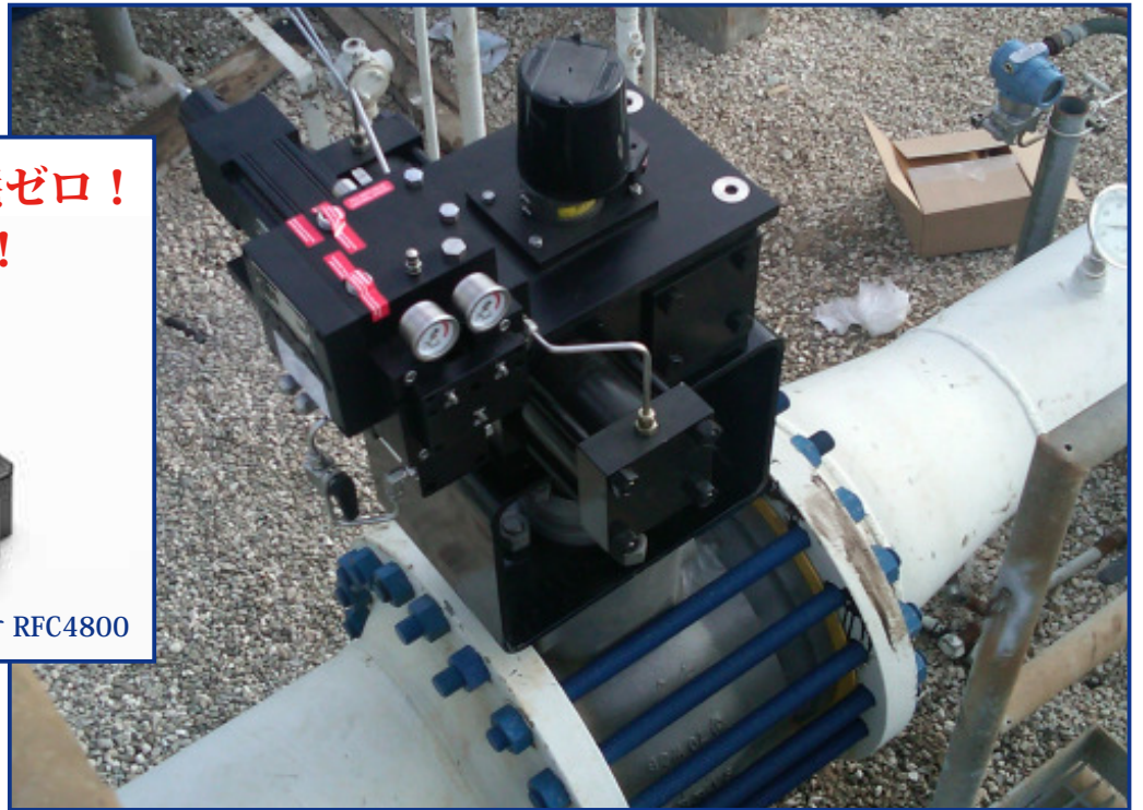
KOSO USA のバルブ開閉システムに Novotechnik 社の RFC4800 が採用されました。
